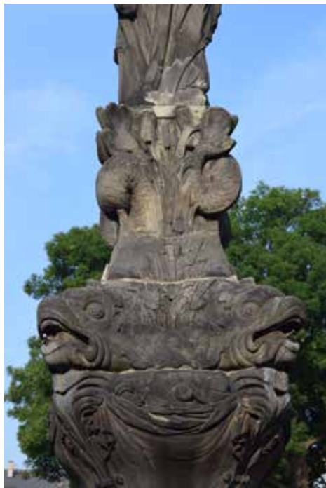
Rybí hlavy sloužící jako chrliče vody
